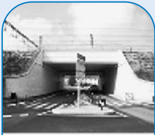
Élargissement du pont-rail rue Anatole France
