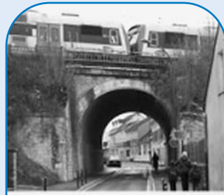
Élargissement du pont-rail rue de la Mairie
