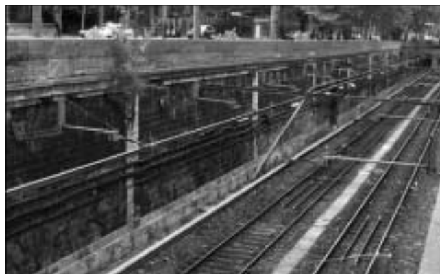
Les travaux Castor
